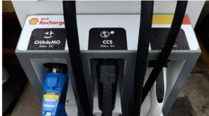
Según **movilidadeléctrica.com**, actualmente existen varios formatos de carga rápida diferentes. La carga con corriente continua es más potente que con corriente alterna. Actualmente con esta última, el tope está en los 43 kW, mientras que en continua se habla de hasta 400 kW. Esas cifras representan, al final, tiempo de carga, algo que es imprescindible acortar para poder viajar.
